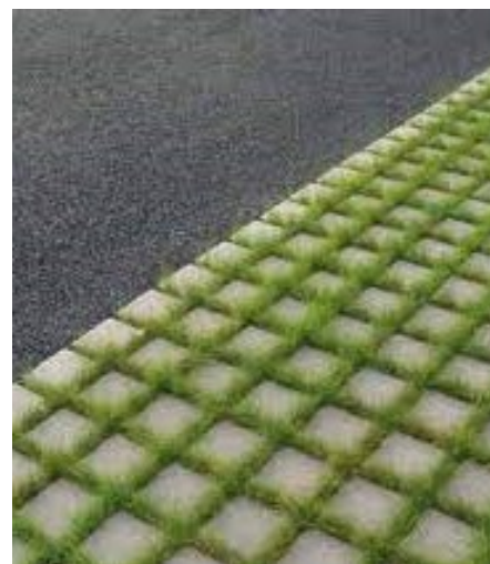
Pysäköintiruutujen pintamateriaaliksi suositellaan nurmikiveystä.
